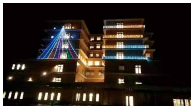
竣工前年のクリスマスには現場でイルミネーションを披露した。病院の完成に期待を寄せる地元市民との交流が深まるなか、この時も大きな反響があったと藤本所長は話す
